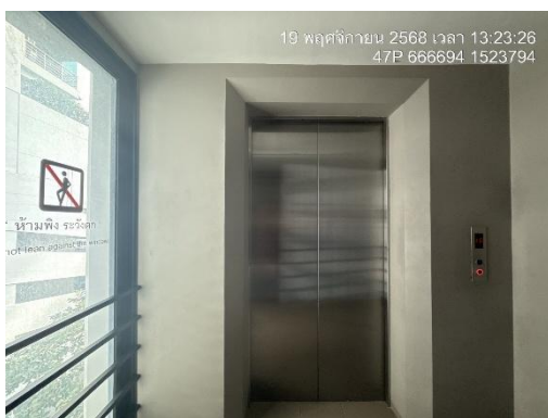
รูปที่ 32 ลิฟต์ดับเพลิง
