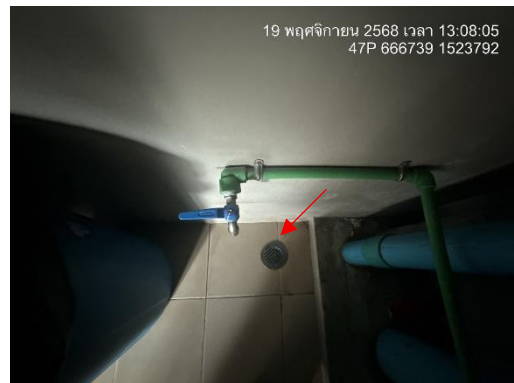
รูปที่ 25 ท่อรวบรวมน้ำเสีย
