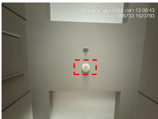
รูปที่ 36 เครื่องตรวจจับควัน (Smoke Detector)
