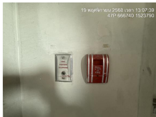
รูปที่ 37 ติดตั้งเครื่องแจ้งเหตุโดยใช่มือดึง (Fire Alarm Manual Station)
