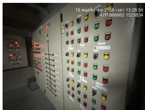
รูปที่ 13 มิเตอร์และตู้ควบคุมระบบบำบัดน้ำเสีย
