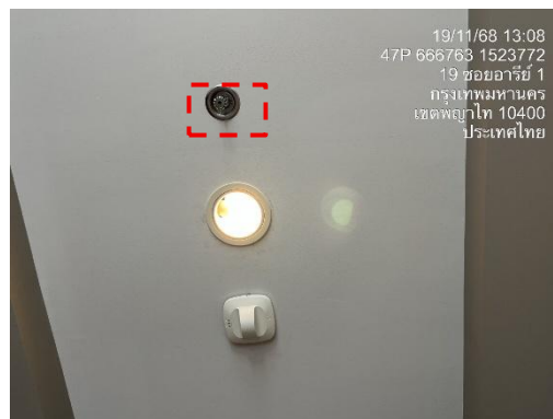
รูปที่ 31 ระบบหัวกระจายน้ำดับเพลิงอัตโนมัติ (Sprinler System)
